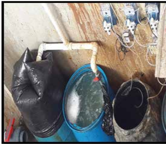
BOMBAS DOSIFICADORAS PARA LOS COAGULANTES Y FLOCULANTES
